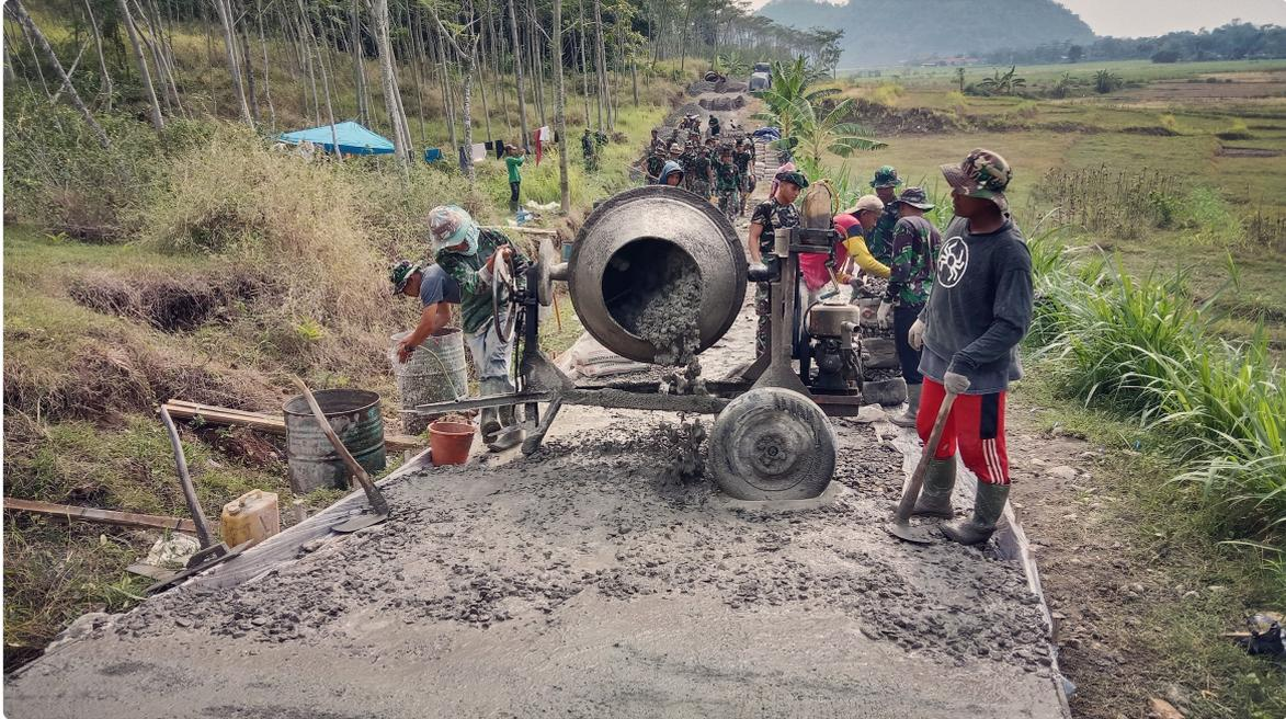
Lanjut, Praka Handoko mengatakan, dengan alat mesin pengaduk campuran atau sering disebut molen dipindahkan ke area yang sesuai dengan posisi yang diinginkan agar mesin tersebut dapat beroperasi dengan lancar sehingga memacu lancarnya pasokan adukan untuk pengerjaan pengecoran jalan.
