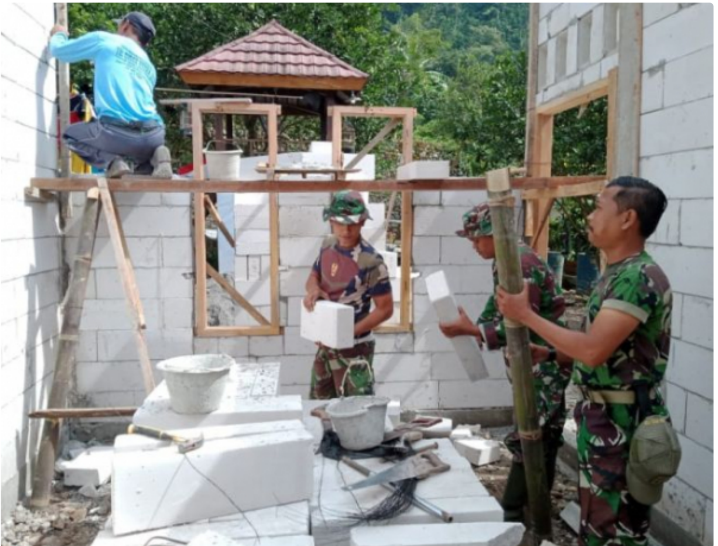
Anggota satgas TMMD Sengkuyung Tahap II dengan bergotong royong pemasangan herbal
